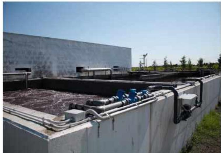
O processo implementado consiste na tamisagem do efluente e acondicionamento em tanque de homogeneização. Segue-se um reactor biológico com lamas activadas do decantador secundário.
